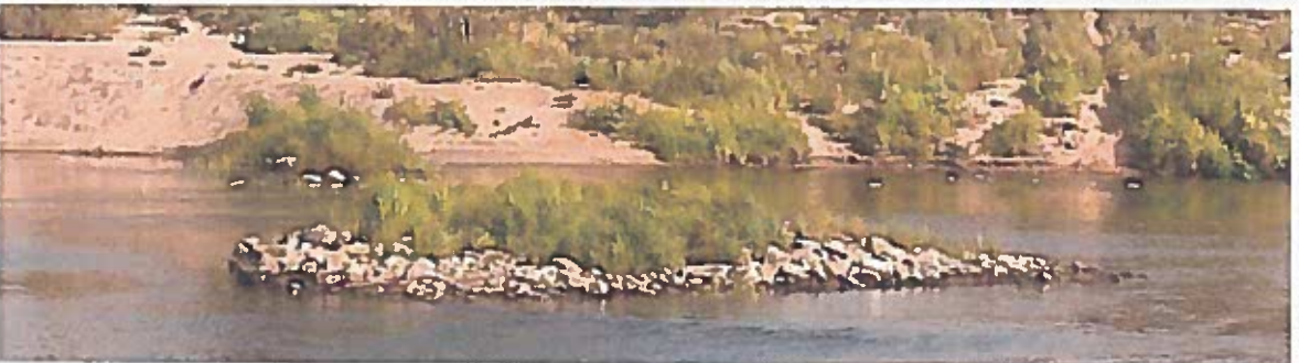
Beveik visai sugadinta buna. Vanduo teka iš visų pusių. Nebeatlieka savo funkcijos
